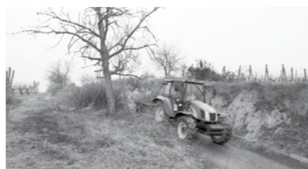
NEBÝVALE TEPLÉ POČASÍ LETOŠNÍHO LEDNA PŘÁLO PRACÍM V TERÉNU, NA ŘADU PŘÍŠLA ÚDRŽBA POLNÍCH CEST.
